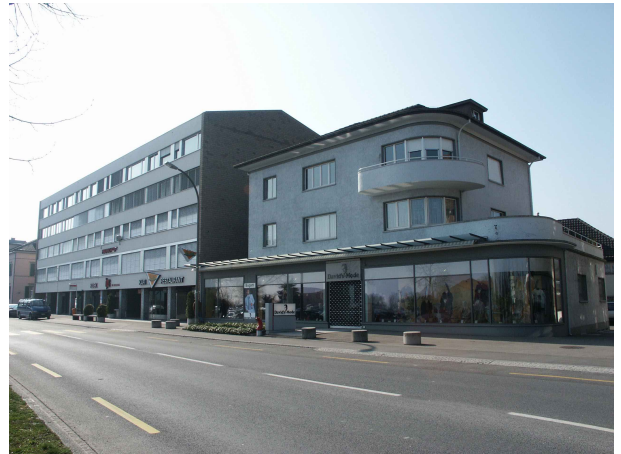
Abb 56. Hauptstrasse 82, 84. Heute. Foto: Jörg Neuweiler
