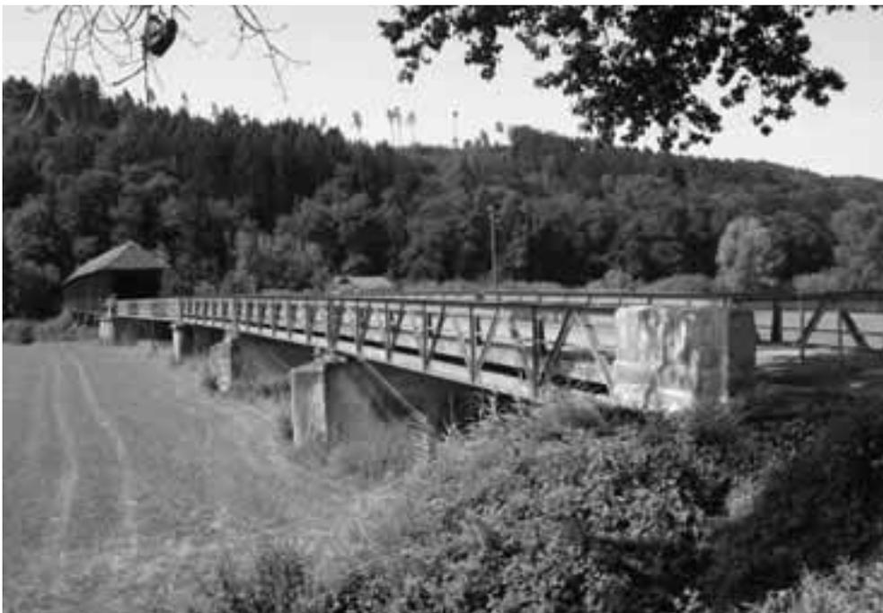
Abb. 9–11 (von oben): Die 1811 von Johann Jakob Zingg fertig gestellte jüngere Sitterbrücke von Bischofszell war eine Meisterleistung der Zimmermannskunst mit einem innovativen Tragwerk, das erst später im Stahlbrückenbau weiterentwickelt wurde. Ihr Abbruch im Jahr 1958 bedeutet aus technikgeschichtlicher Sicht einen enormen Verlust für die thurgauische Brückenlandschaft.
