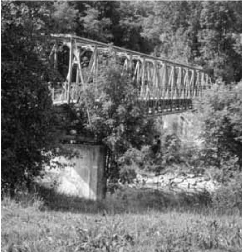
Abb. 16 (oben): Der 1897/98 erbaute Thursteg von Buhwil wird von einem Fachwerkträger gebildet, der mit Rechteckrahmen versteift ist, innerhalb derer die Laufbahn liegt.
