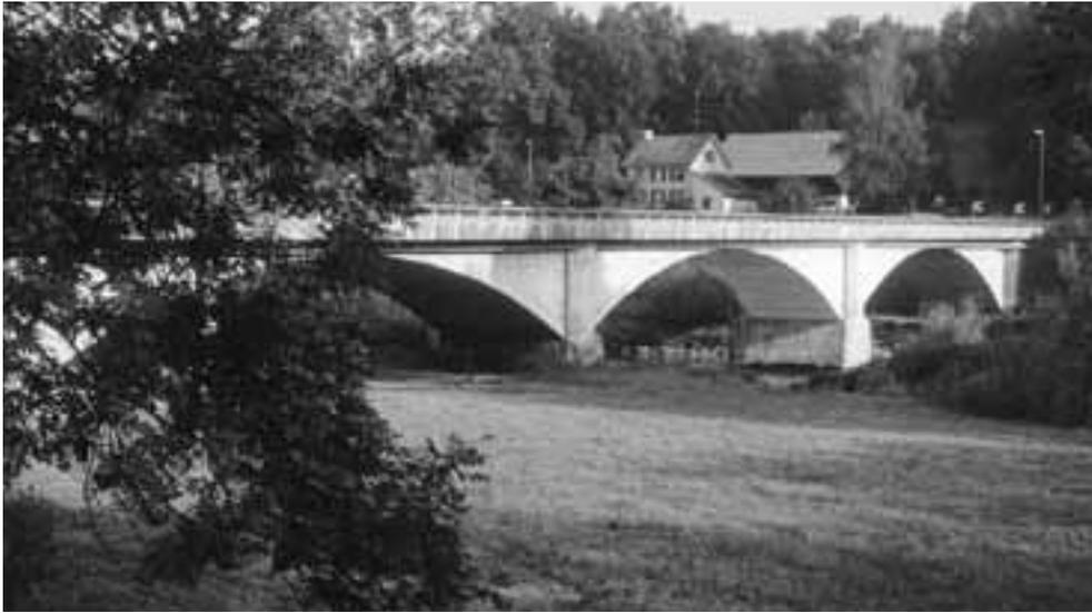
Abb. 18 (linke Seite, links): Die 1911 auf der Kantonsgrenze zu St. Gallen erbaute «Rotenbrücke» über die Sitter bei St. Pelagi-berg ist die erste grosse Bogenbrücke aus armiertem Beton im Thurgau.
