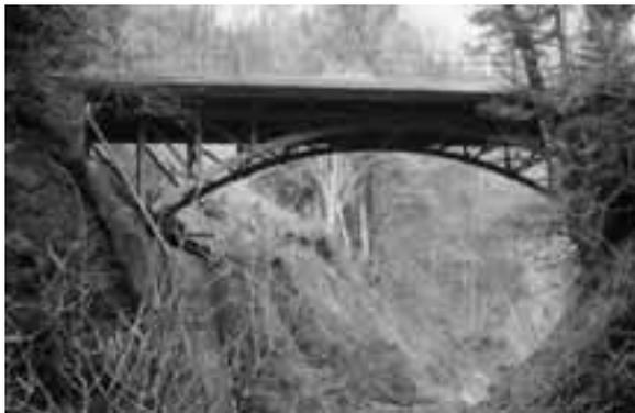
Abb. 12 (ganz oben): Der «Badsteg» über die Murg in Frauenfeld wird von einem Stabbogen (so genannter «Langerbalken») gebildet, bei dem die Enden des Tragbogens fest mit den horizontalen Längsträgern vernietet sind. Der Steg bestand bereits um 1860 (vgl. Abb. 2) anstelle der heutigen Bahnhofbrücke. Er wurde 1920 an die heutige Stelle versetzt und dabei um zwei Gefache verkürzt.
