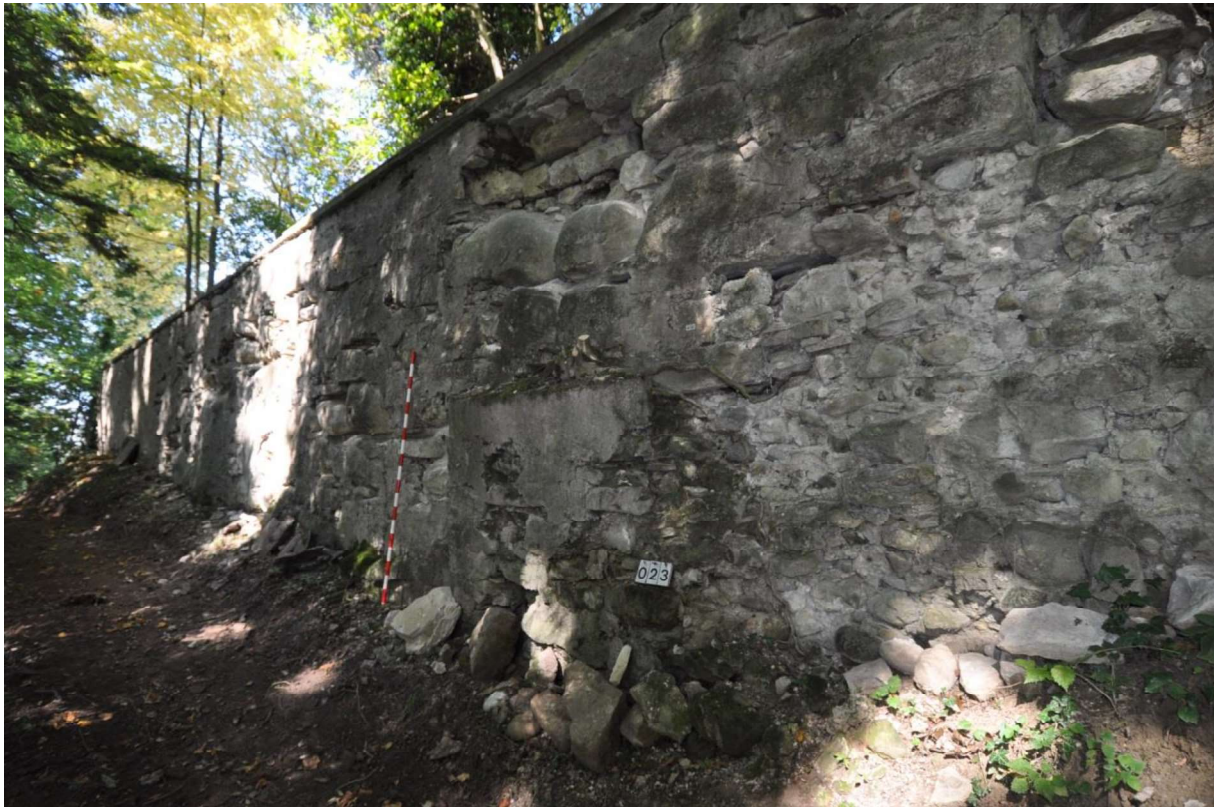
Südmauer der Terrasse, die mächtigen Blöcke sind die Grundmauern des Bergfriedes der Burg.
