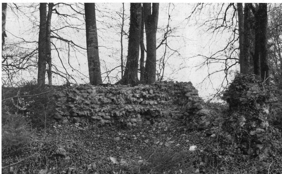
6: Blick ins Innere des Torturms (A) von Westen. Zustand 2008.
